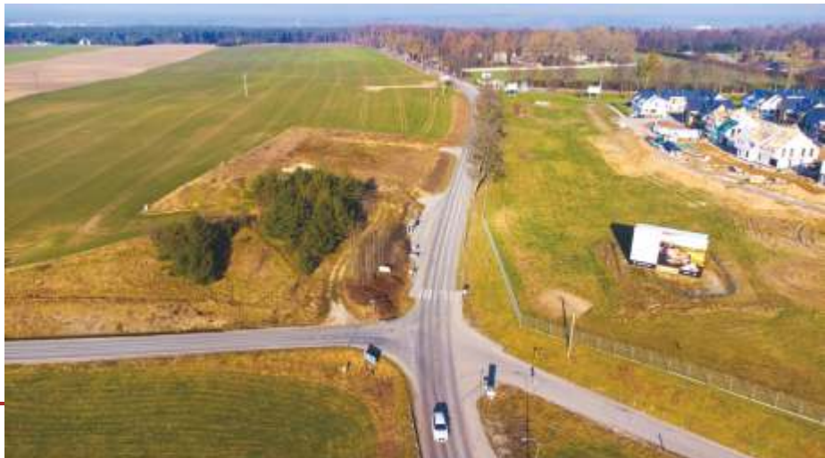
Droga powiatowa na odcinku Gowino – Pętkowice, która ma być przebudowana w latach 2025-2026
